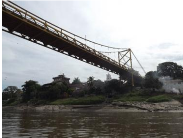
Puente sobre el río Magdalena. Fuente: equipo consultor
